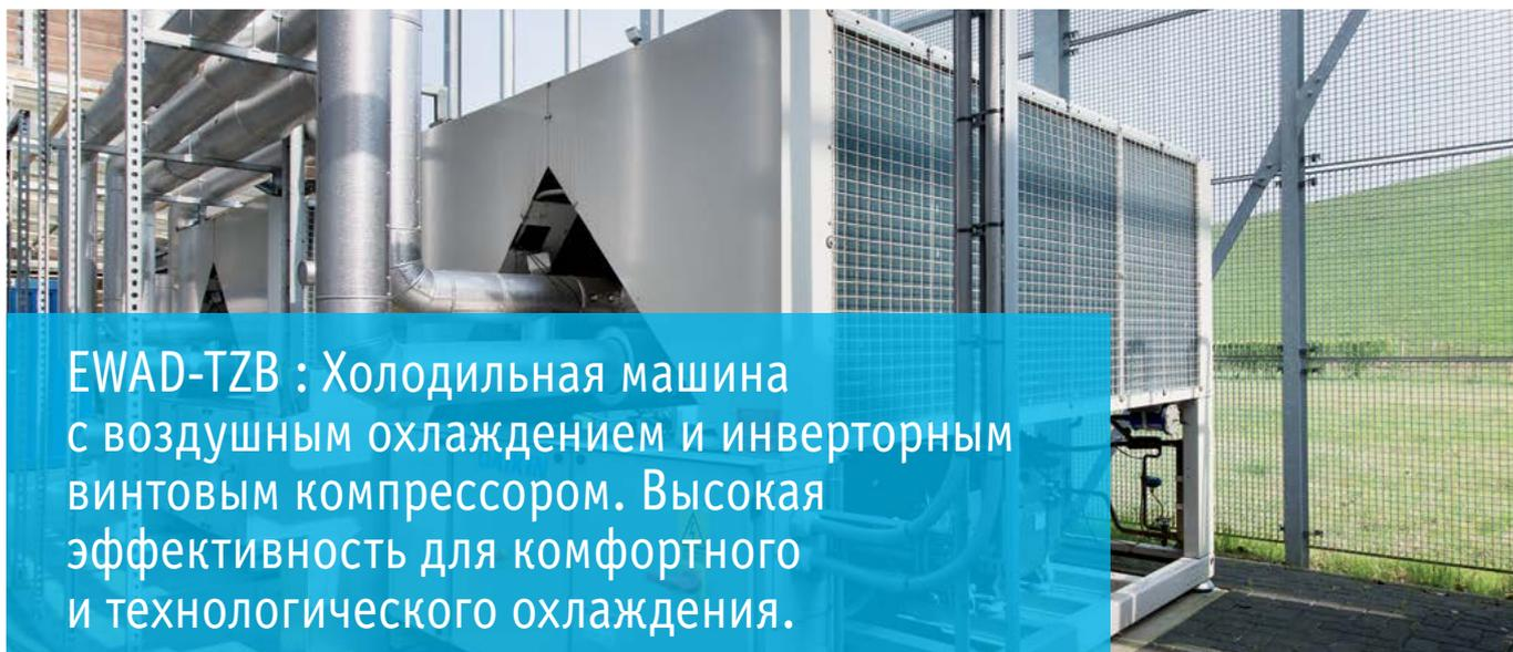
EWAD-TZB : Холодильная машина с воздушным охлаждением и инверторным винтовым компрессором. Высокая эффективность для комфортного и технологического охлаждения.
