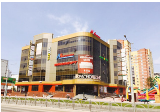
ТОРГОВЫЙ ЦЕНТР «КРАСНОЛЕСЬЕ» Екатеринбург, 700 квТ
