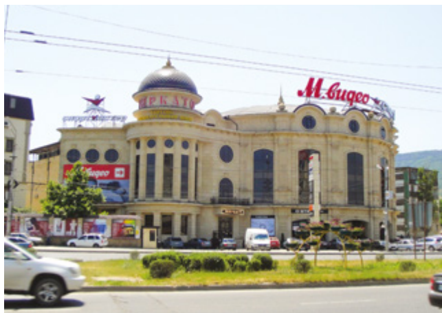
ТОРГОВЫЙ ЦЕНТР «МИРКАТО» Махачкала, 590 квТ
