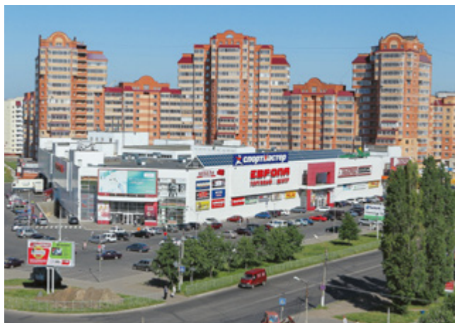
ТОРГОВЫЙ ЦЕНТР «ЕВРОПА 26» Железногорск, 320 квТ
