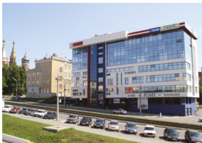
БИЗНЕС-ЦЕНТР «НАЙДИ» Ижевск, 498 кВт
