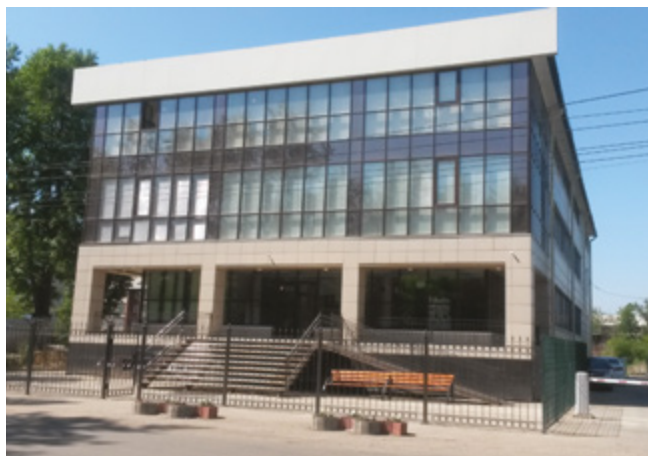
КОЛ-ЦЕНТР «ТЕЛЕ2» Иркутск, 300 квТ
