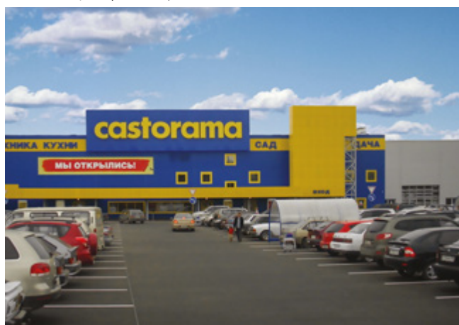
ГИПЕРМАРКЕТ СТРОИТЕЛЬНЫХ ТОВАРОВ «КАСТОРАМА» Уфа, 1 МВт
