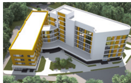
Здание поликлиники №1 «Одинцовская ЦРБ», Московская область
