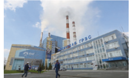
Рефтинская ГРЭС, Свердловская обл.
