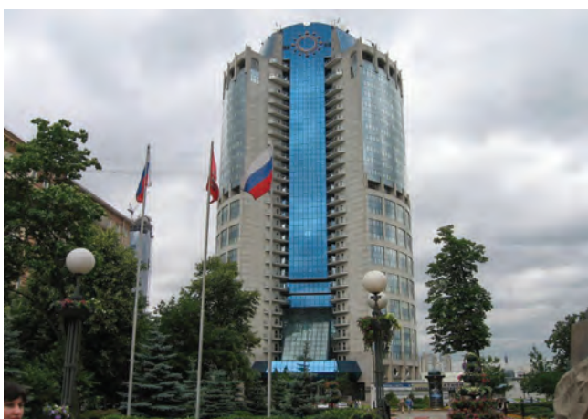
ГУП «МОСВОДОСТОК» Москва, 440 кВт
