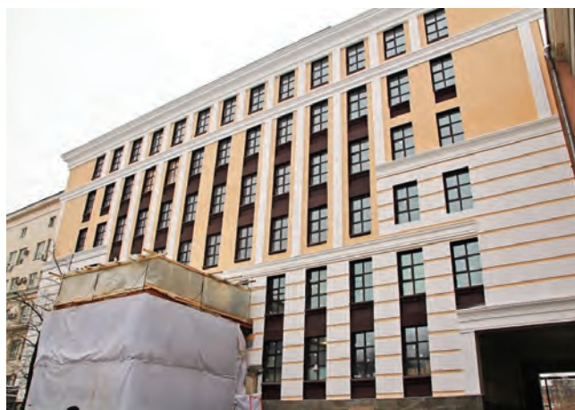
БИЗНЕС-ЦЕНТР «БАСМАННЫЙ ПАРК» Москва, 495 кВт
