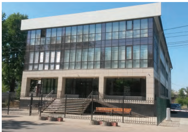
КОЛЛ-ЦЕНТР «ТЕЛЕ2» Иркутск, 300 квТ
