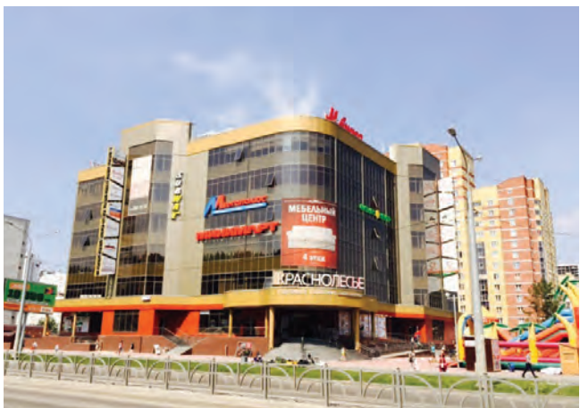
ТОРГОВЫЙ ЦЕНТР «КРАСНОЛЕСЬЕ» Екатеринбург, 700 квТ
