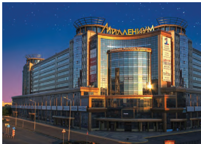
ТОРГОВЫЙ ЦЕНТР «МИЛЛЕНИУМ» Омск, 410 квТ
