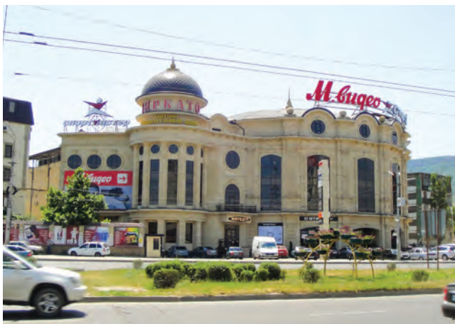
ТОРГОВЫЙ ЦЕНТР «МИРКАТО» Махачкала, 590 квТ
