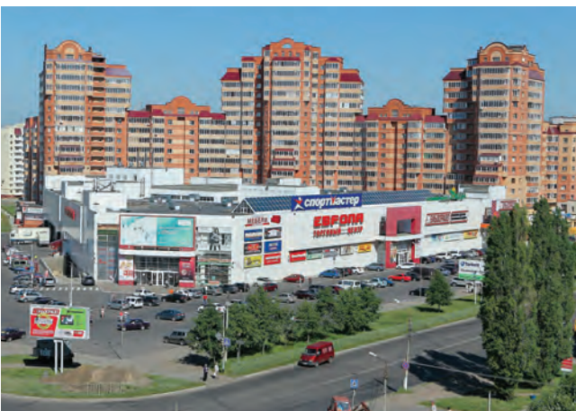
ТОРГОВЫЙ ЦЕНТР «ЕВРОПА 26» Железногорск, 320 квТ
