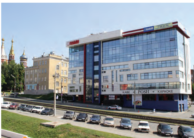
БИЗНЕС-ЦЕНТР «НАЙДИ» Ижевск, 498 квТ
